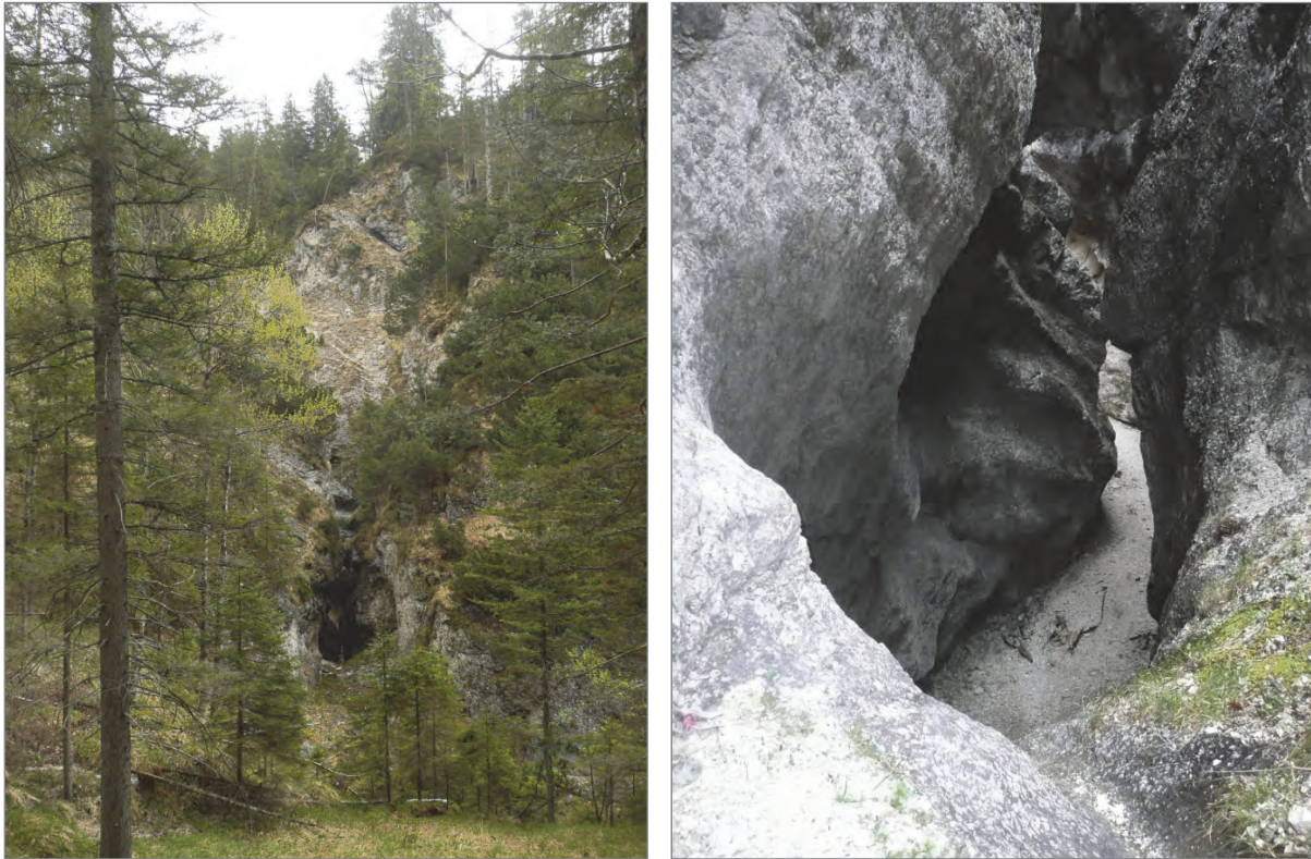
Abb. 6e/f: Der Eingang zum Felsabschnitt der „Trockenen Klamm“ (links) und die Wasserfallstufe mit ausgekolktem Prallbecken (rechts).
