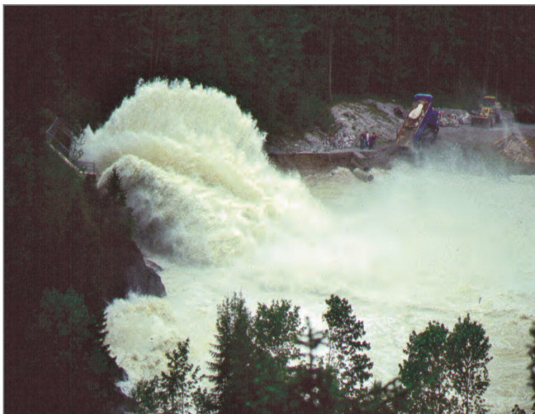
Abb. 4: Hochwasserentlastung 1999 ( 260 \text{ m}^3/\text{s} ).
