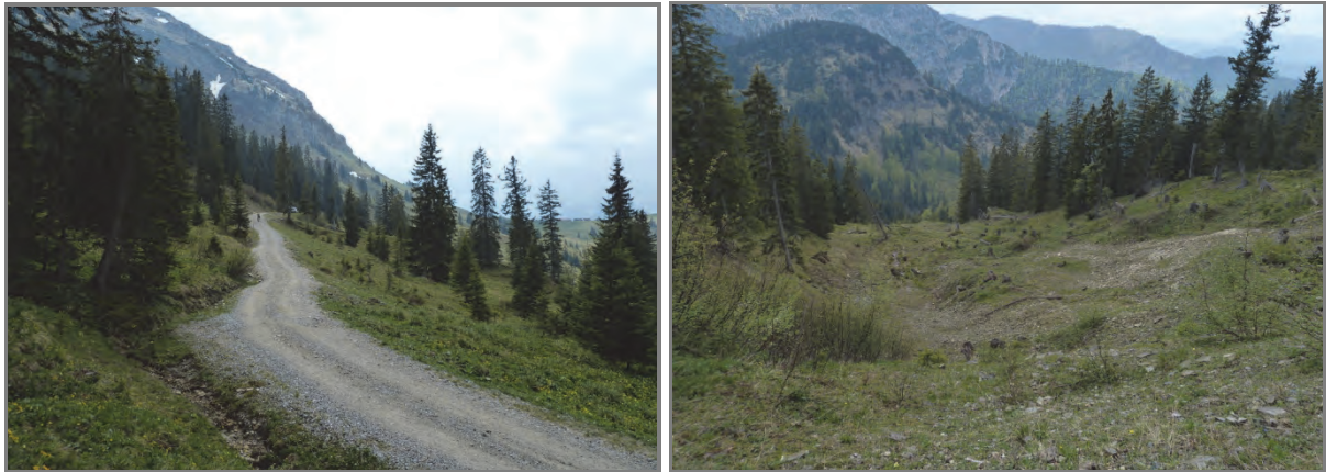
Abb. 3: Rutschareal in Kössen-Fm. nördlich des Rotwandalm-Hochlegers; man beachte den unruhigen Verlauf des Forstweges (linkes Bild) durch die rezenten Bewegungen sowie die unruhige Hohlform (rechtes Bild) im abgeholzten Bereich mit Resten von „betrunkenem“ Wald.
