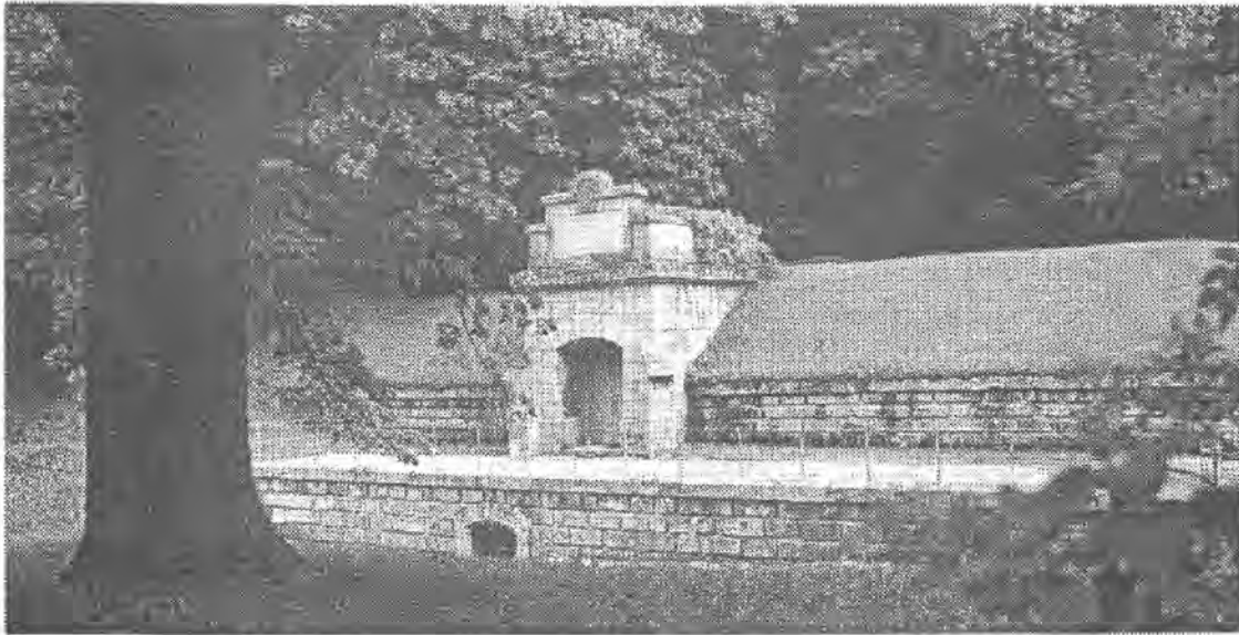
Abb. 3: Die Quellfassung in Kaiserbrunn; erste gefasste Quelle der I. Wiener Hochquellenleitung.
