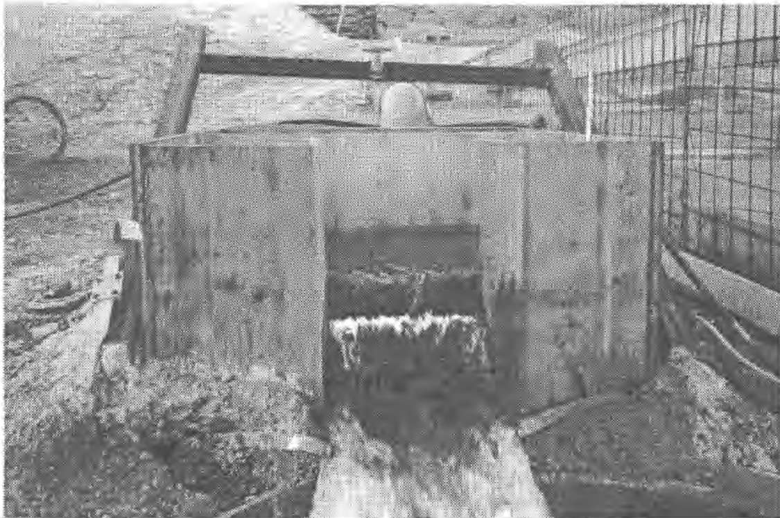
Abb. 7: Tunnel Semmering (Scheiteltunnel) - Meßkiste im Portalbereich Maria Schutz.
