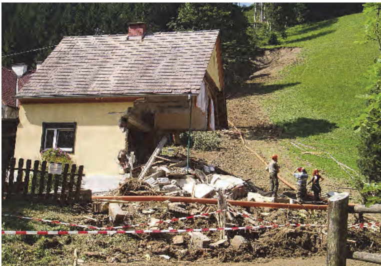
Abb. 2: Ein durch eine Hangmure zerstörtes Haus in der Gemeinde Gasen. Zwei Menschen kamen durch diese gravitative Massenbewegung ums Leben (Fotoquelle: A. Koçiu, GBA).
