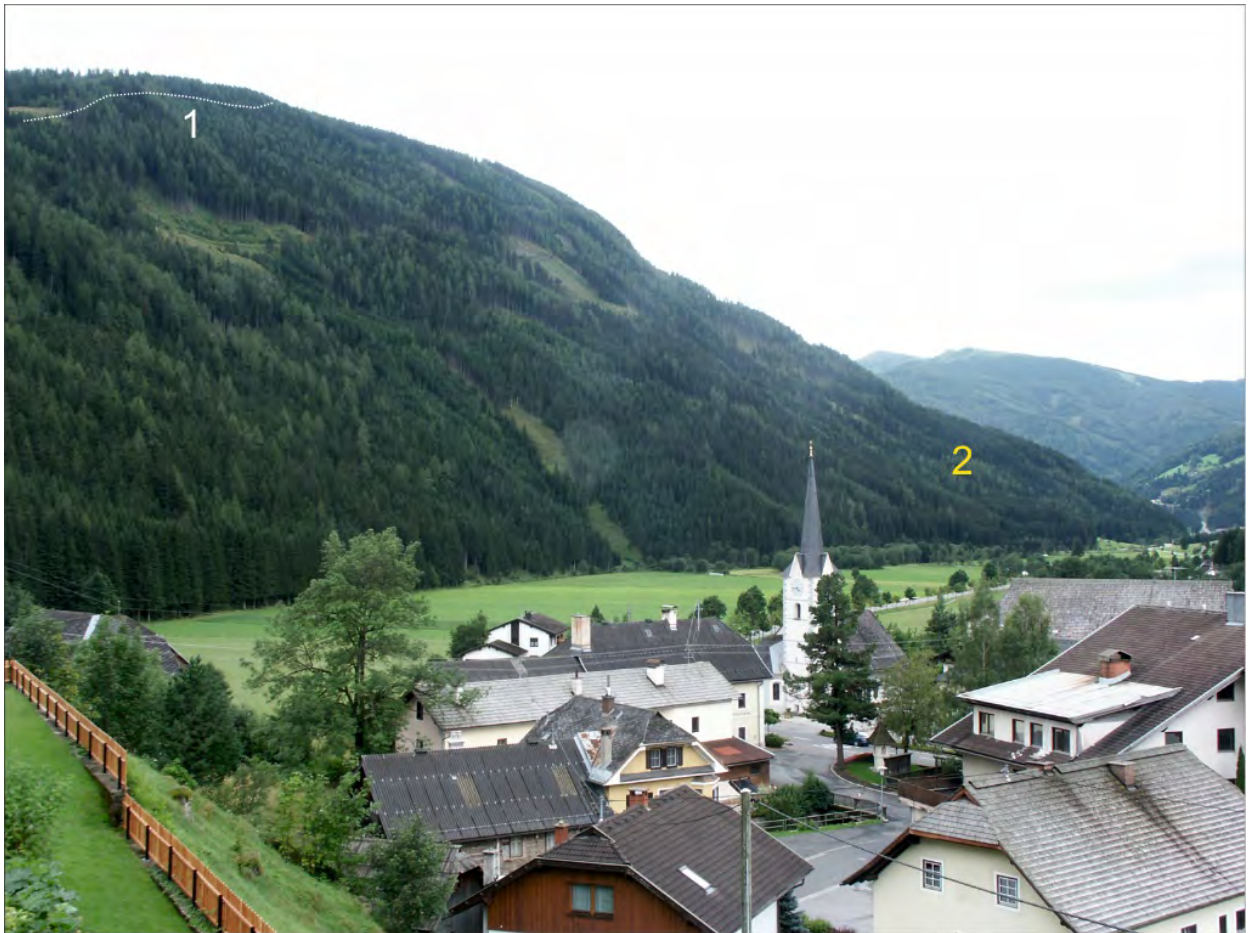
Abb. 17: Die Westflanke des Hölleberges mit Abrisskante(n) (1) und Talzuschub (2).
