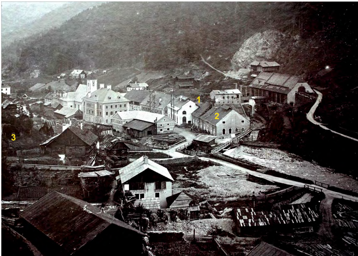
Abb. 7: Historische Ansicht (1895) vom Hüttenkomplex Turrach (1: Hochofen, 2: Bessemeranlage, 3: Erzaldensturz am Ende der Förderseilbahn) (Archiv Albert Schedl).
