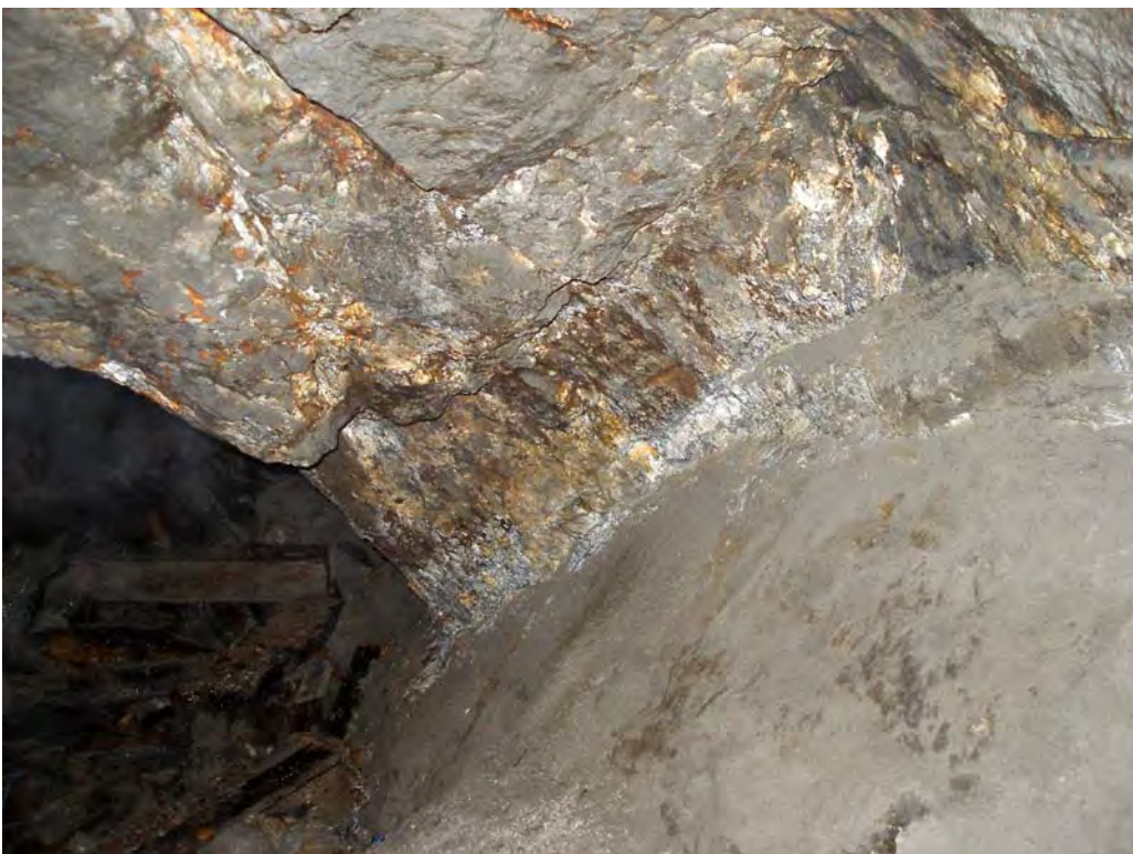
Abb. 55. Kupfererzgang (Gangbreite 20 cm) im ehemaligen Bergbau Buchberg (Foto: L. Weber).
