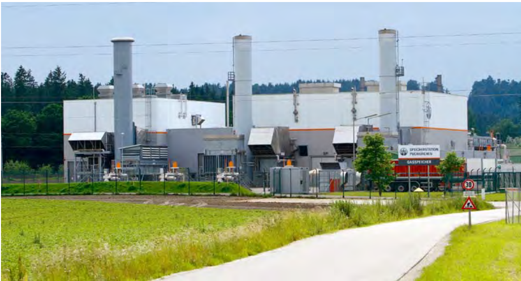
Abb. 44. Erdgasspeicher Puchkirchen/ Haag (Foto: Rohöl-Aufsuchungs AG).
