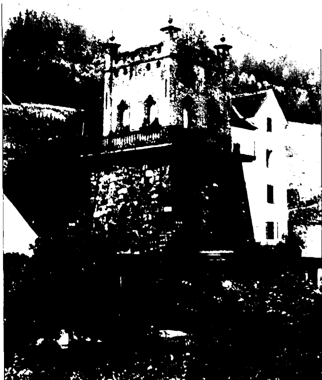
Abb. 2. Hochofenanlage in St. Gertraud (Lavanttal/Kärnten) um 1933. Hochofen (Bidmite), bestehend aus Ofenstock (Gewölbe durch Bäume verdeckt), Fluchtbalkon und Rauchhaube; Aufzugshaus (rechts hinter dem Hochofen).
