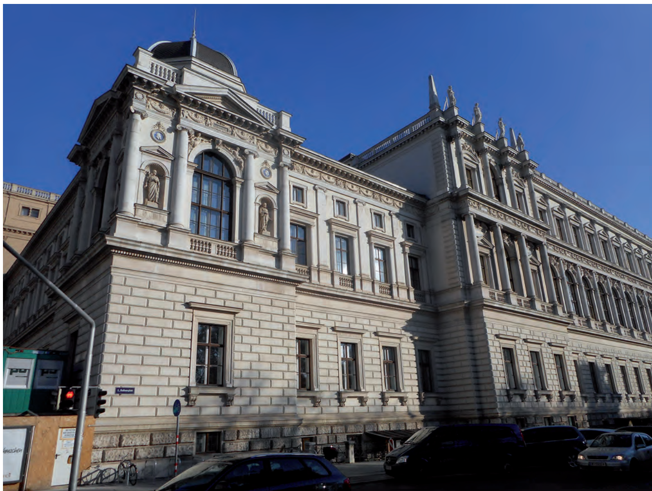
Abb. 21. Die südliche Front (Grillparzerstraße, Rathausplatz) der Universität Wien am Universitätsring. Im Eckrisalit des Hochparterres befanden sich das Vorstandszimmer und die Sammlungsräume, im Mittelrisalit der gemeinsam mit der Geologie genutzte Hörsaal (Foto T. Hofmann).
