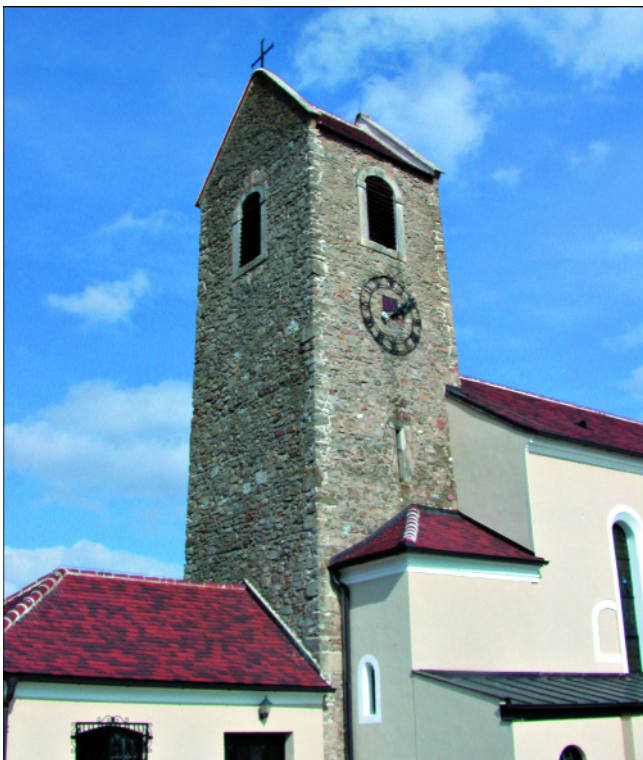
Abb. 9. Hohenwarth: Kirchturm (14. Jahrhundert). Ort- und Bruchstein-Mauerwerk aus verhärteten Lagen der Hollabrunn-Mistelbach-Formation.
