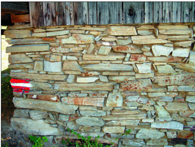
Abb. 3. Steinegg. Bruchstein-Mauerwerk aus Granulit.
