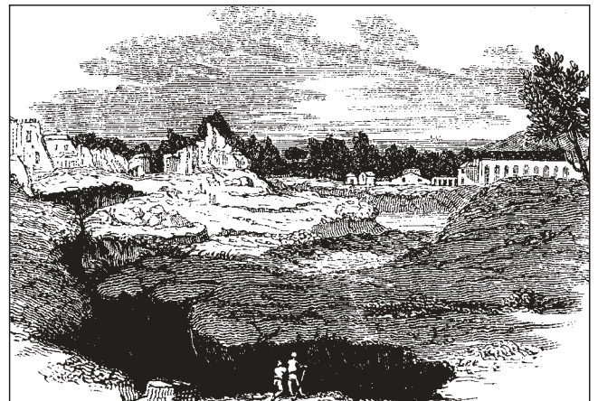
Abb. 27. Tiefe Spalte bei Polistena, entstanden bei dem Erdbeben von 1783. Nach LYELL (1834).
