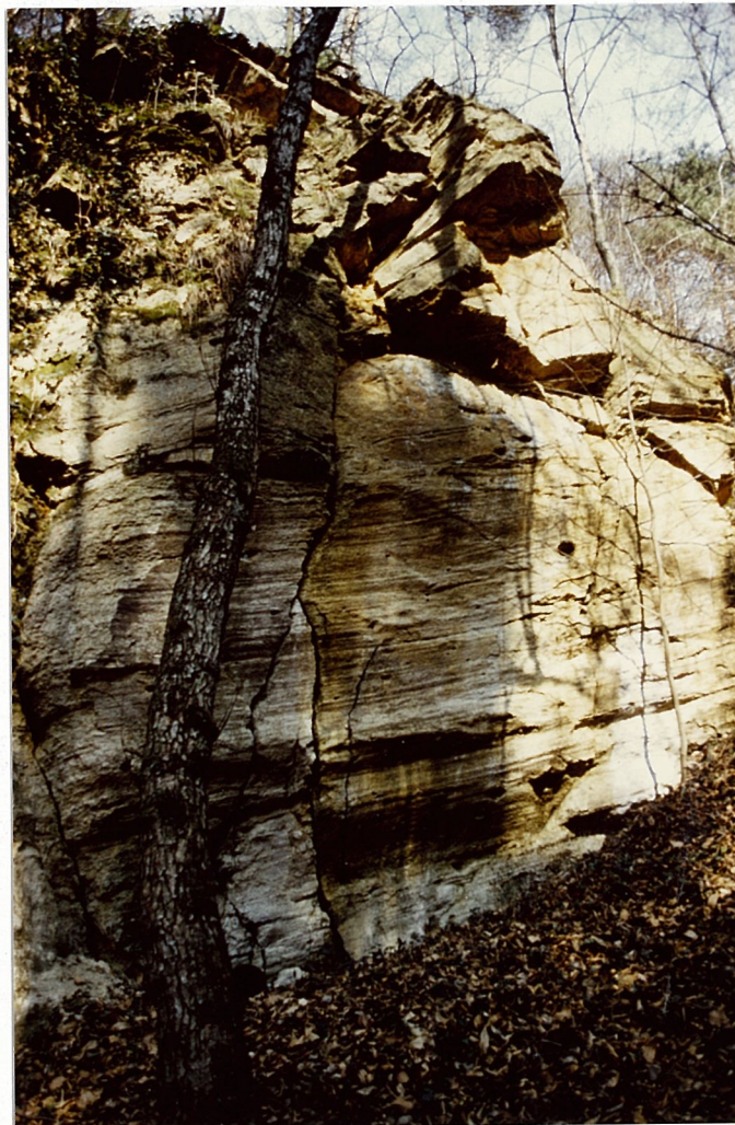
Abb. 50: Das "Schichtungsgefüge" im Liparit des Schaufelgrabens entspricht dem magmatischen Fließgefüge. \perp Senkrecht dazu treten Kluftsysteme auf. Eines (1) ist klaffend, wellig und mit Montmorillonit-Füllungen ausgestattet.
