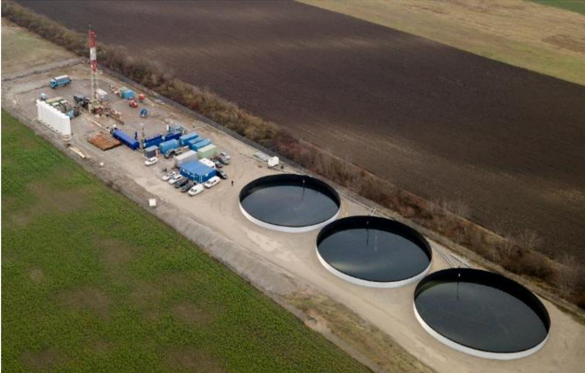
Abbildung 31: Fördertest aus einer bestehenden Bohrung. Die Becken im Vordergrund dienen der Zwischenspeicherung des geförderten Thermalwassers aus dem Zielreservoir (Quelle: Wien Energie).
