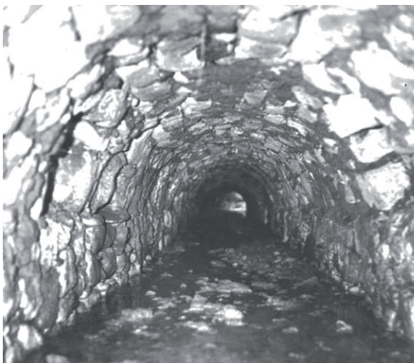
Slika 1. Odvodni kanalizacijski kanala Stari grad, Držičeva poljana
