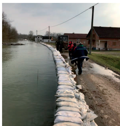
Slika 4. Nadvišenje lijevog savskog nasipa za zaštitu naselja Mlaka kod Jasenovca (ožujak 2018. godine)
