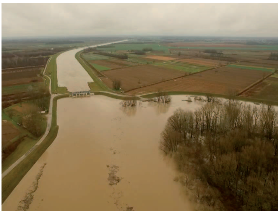
Slika 4. Kontrolirano upuštanje velikih voda rijeke Save putem ustave Prevlaka u prirodno poplavna područja Lonjskog polja
