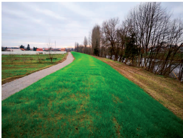
Slika 14. Novoizgrađeni lijevoobalni nasip rijeke Kupe od željezničkog mosta do Brodaraca
