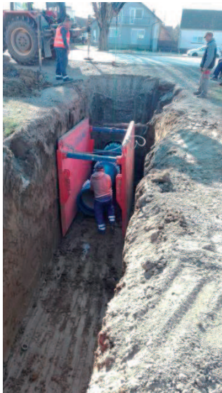
Slike 19. i 20. Izgradnja magistralnog cjevovoda promjera 700 mm u Sikirevcima
