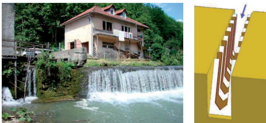
Slika 1. Prag na vodotoku (lijevo) i Denilova riblja staza (desno); prilagođeno prema (Armstrong i drugi, 2010)
