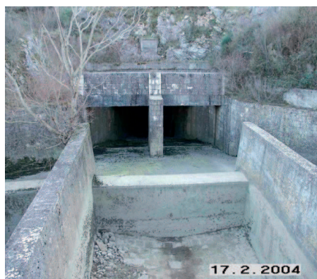
Slika 2. Ulaz u tunel za evakuaciju velikih voda (Foto: Higra d.o.o., Split)
