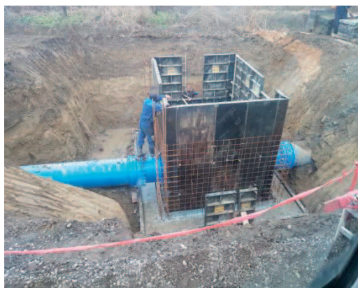
Slike 19. i 20. Izgradnja magistralnog cjevovoda promjera 700 mm u Sikirevcima
