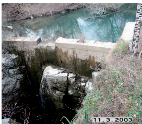
Slika .1 Preljev na ulazu u ponor (Foto: Higra d.o.o., Split)
