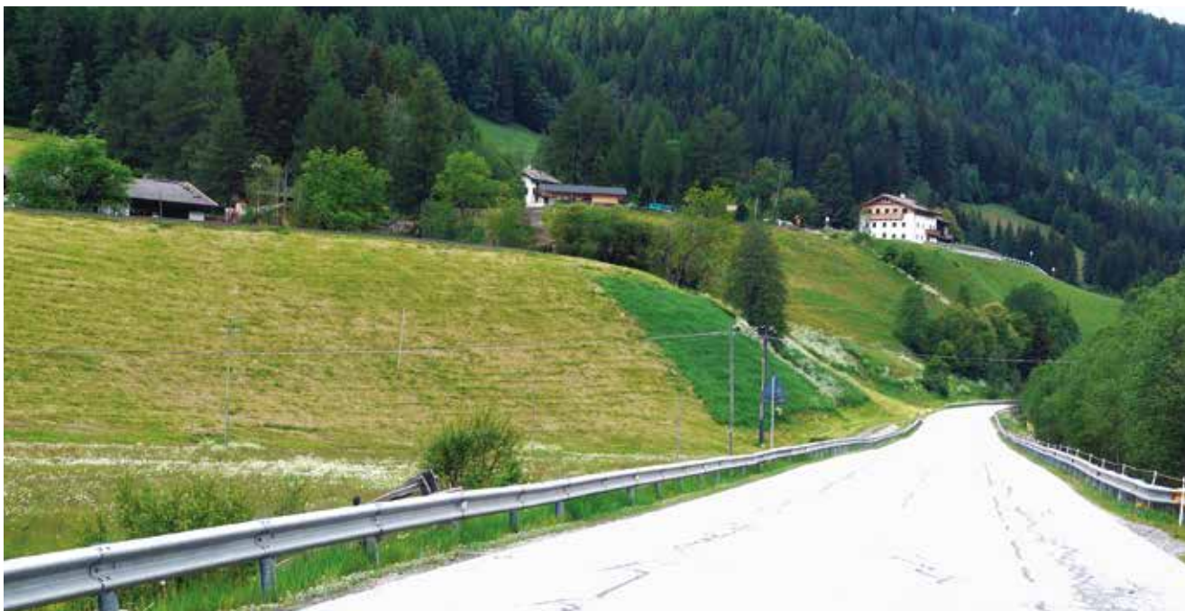
Fig. 17 - Incisione torrentizia - utilizzata dalla viabilità del fondovalle - a spese dei depositi proglaciali (prisma proglaciale di Riva). - The proglacial prismatic body of Riva is longitudinally cut by the Rio di Vizze. The road in the picture runs along the main fluvial deep furrow.
