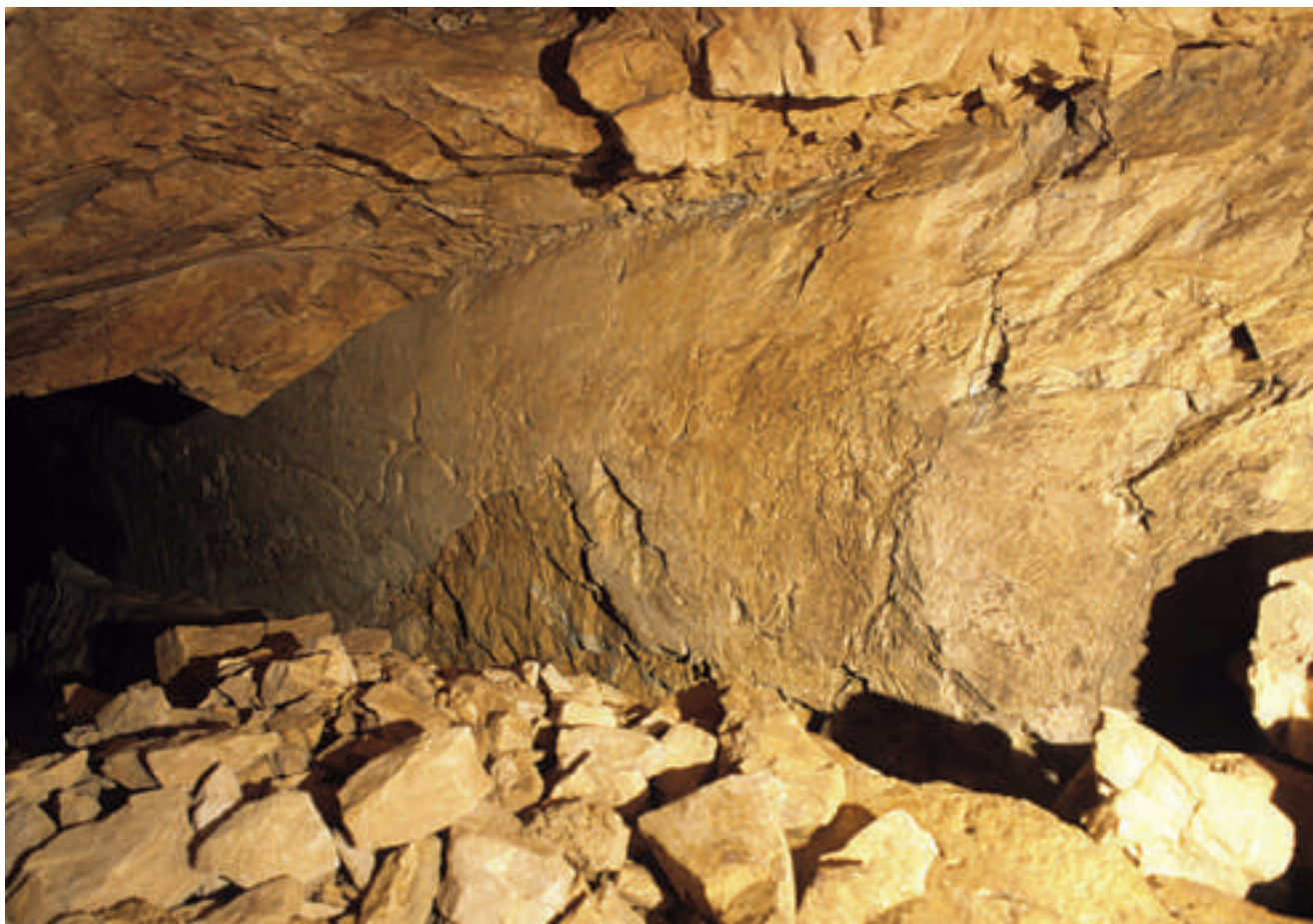
Fig. 15- La parete di faglia (direzione del piano NW-SE) che caratterizza il primo tratto della cavità (fra i punti B e C di Fig. 5b; foto A. D'Andrea).
