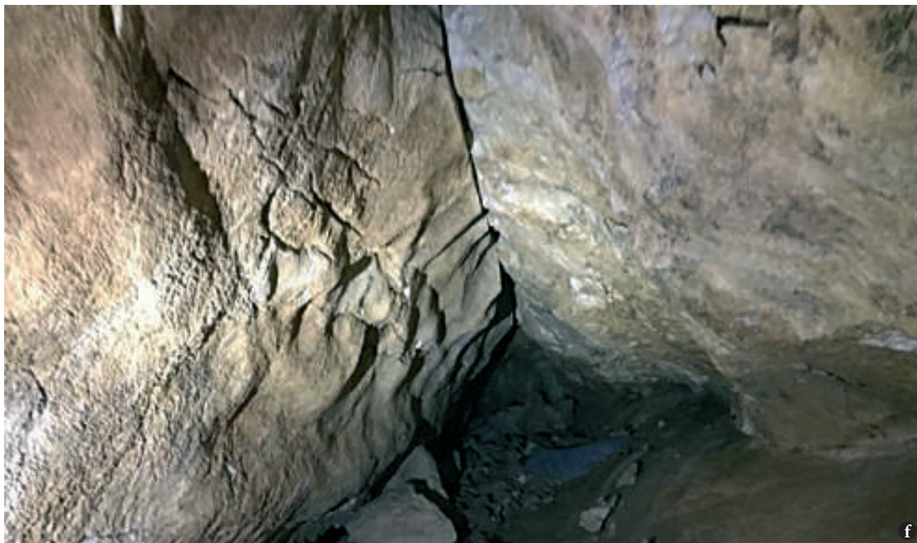
Fig. 14 - Alcuni degli indizi di movimenti recenti presenti nella grotta: a) le cupole nel soffitto della galleria, con tracce di movimenti lungo un piano SW-NE subverticale (dettaglio di f); b) gradino nel soffitto della galleria E; c) evidenti dislocazioni di circa 15 cm nelle cupole presenti nel soffitto della galleria E; d) installazione di un fessurimetro; e) fessurimetro 1, che nel 2019 indica oltre 1 mm di spostamento con un leggero basculamento; f) spostamenti nel soffitto della cavità (foto A. D'Andrea e A. Mocchiutti).
