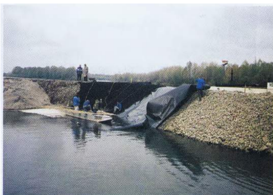
Izgradnja hidrotehničkih objekata
