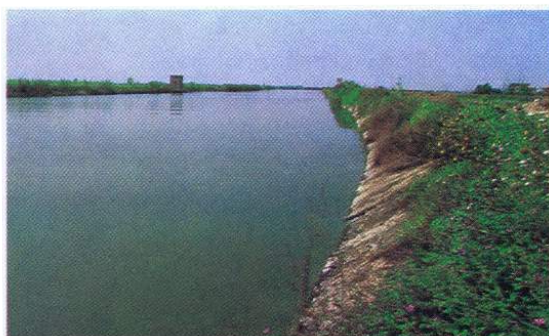
Osiguranje stabilnosti i zaštita od erozije plovnog kanala
