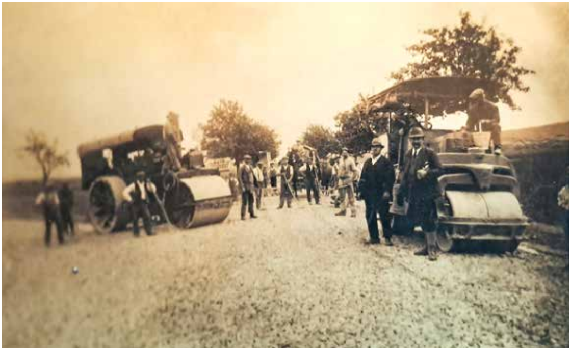
Straßenwalzung bei Leitzersdorf im Jahr 1926: Die Pflasterung der Straßen erfolgte bereits seit Napoleons Zeiten in Schichten mit zumindest drei verschiedenen Korngrößen, um feste Straßendecken für militärische Zwecke zu bauen.
