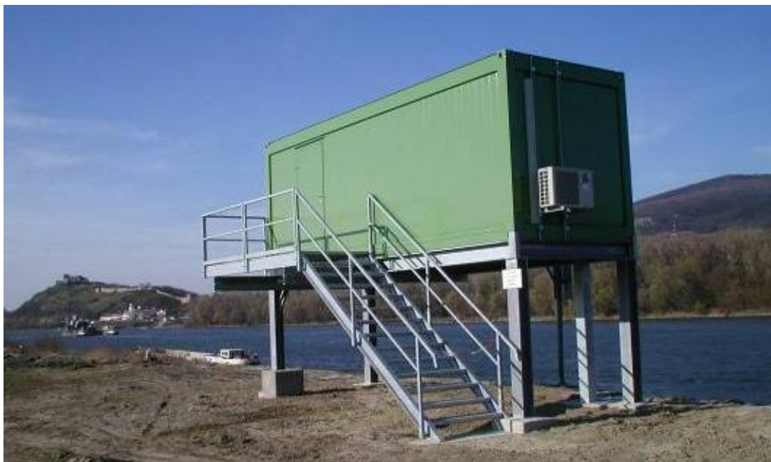
Abbildung 40: Online-Messstation Wolfsthal, Hochwassersituation, © S. Schuster, BMLFUW.
