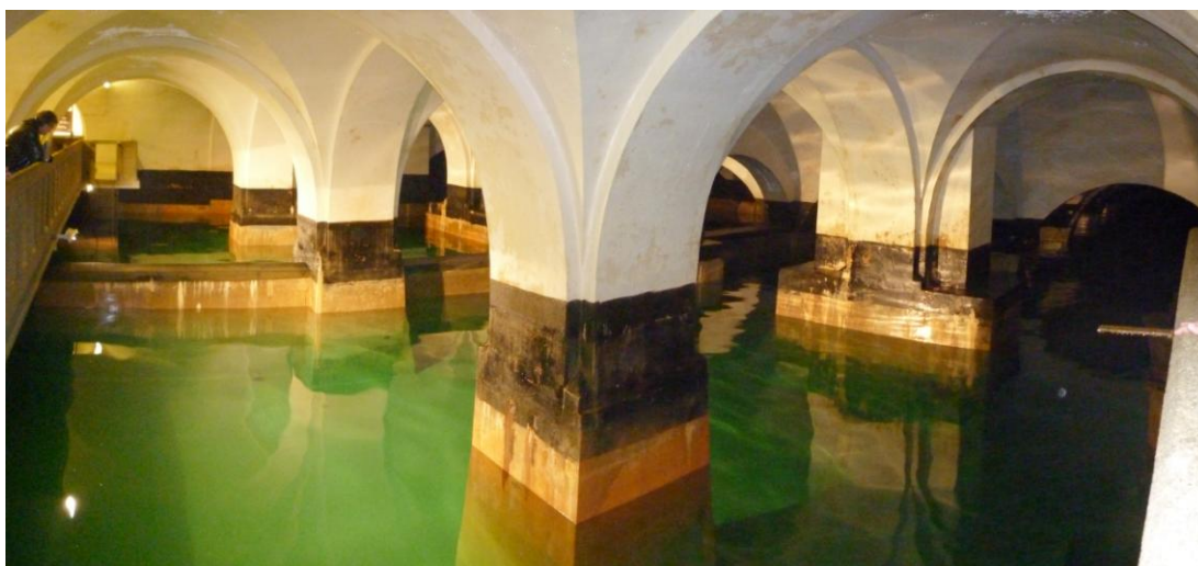
Wasserspeicher am Rosenhügel (Wien), © Ch. Kolesar, Umweltbundesamt.
