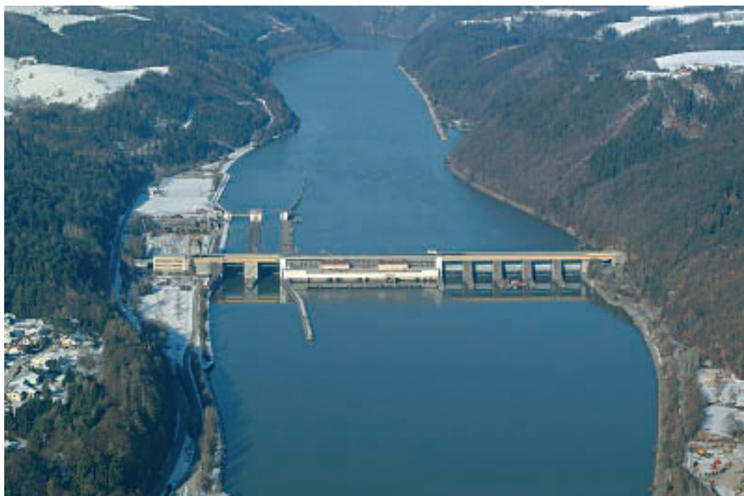
Abb. A/3-2: Kraftwerk Aschach/Oberösterreich, © BMLV Kdo Luftaufklärung.
