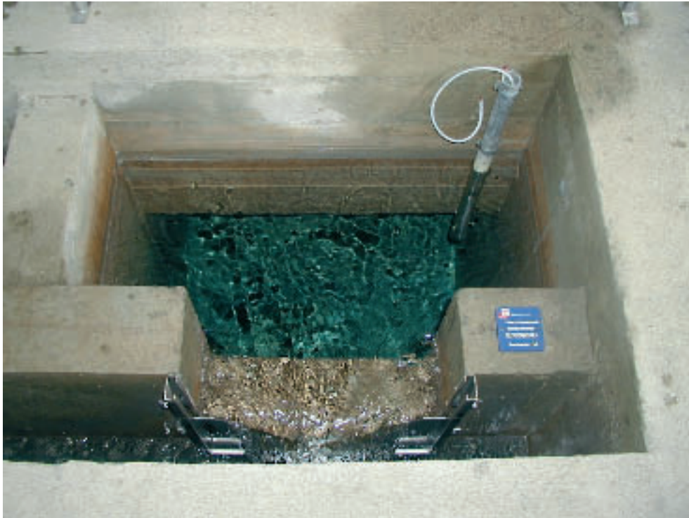
Abb. C/2.2-3: Quellfassung – Messstelle WGEV, © Amt der Tiroler Landesregierung.
