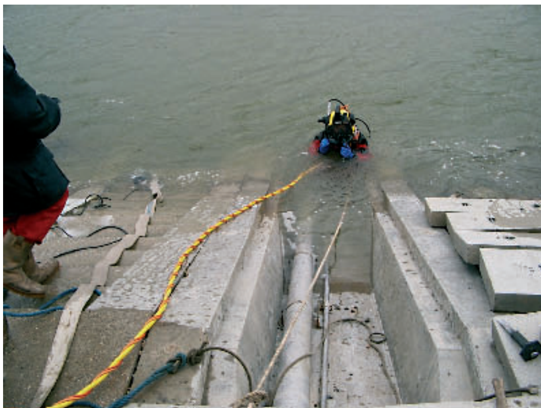
Abb. A/4.4-12: Donau – Reparaturarbeiten Online-Messstation Wolfsthal, © Schuster.
