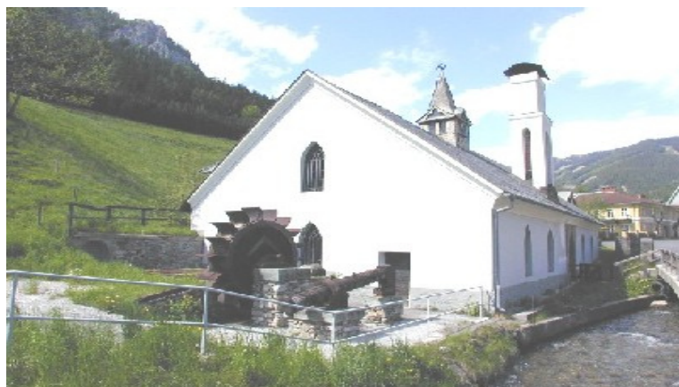
Abb. 9: Vordernberg Lehrfrischhütte: Diente dem praktischen Unterricht an der Steirisch - Ständischen Montanlehranstalt. Prof. Peter Tunner (1809 bis 1897) ließ die Lehrfrischhütte bauen, die mit einem Schwanzhammer ausgestattet war.
