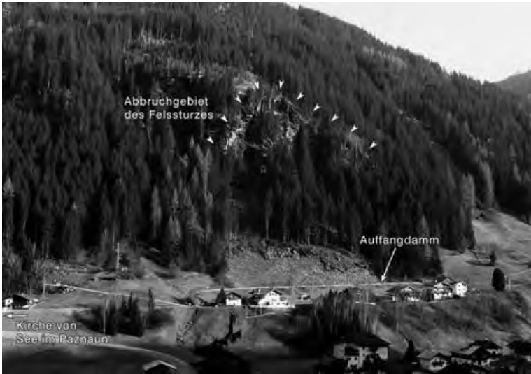
Abb. 25. Felssturzgefährdete Wand über See i. Paznauntal und Schutzbauten (Damm, Steinschlagnetze). Foto: A. GRUBER (2010).
