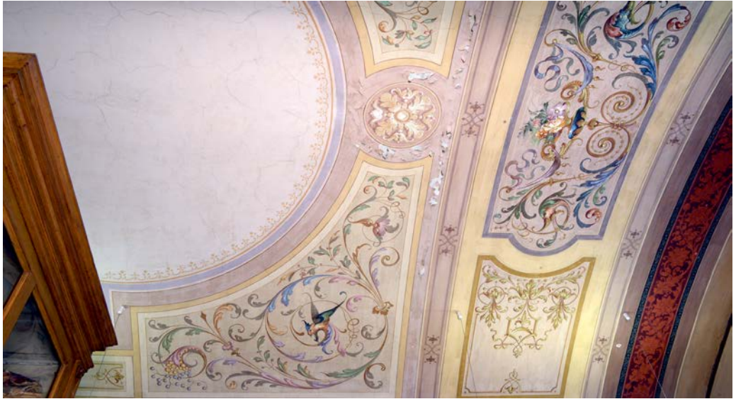
Abb. 16: Deckenmalerei im Raum 233 (vgl. Abb. 1), Foto: Alice Schumacher
