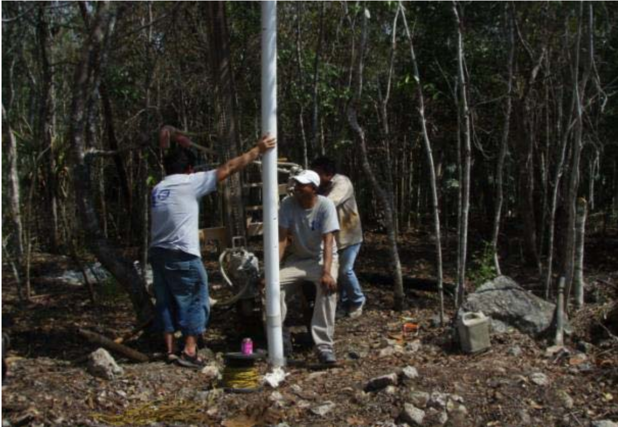
Abbildung 26: Einsetzen der Schlitzrohre in das Bohrloch TU2
