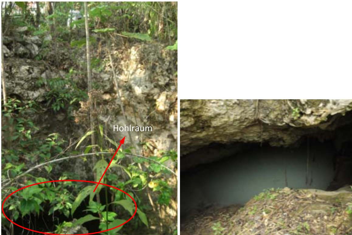
Abbildung 17: Hohlraum zwischen Profilmeter 7 und 14 (links), Detailansicht mit Grundwasserspiegel (rechts)
