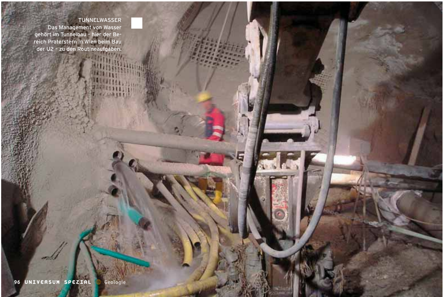
UNTER DEN DONAUKANAL Die Querung des Donaukanals durch die Linie U2 stellte die Ingenieure des Wiener U-Bahn-Baus vor große Herausforderungen.
