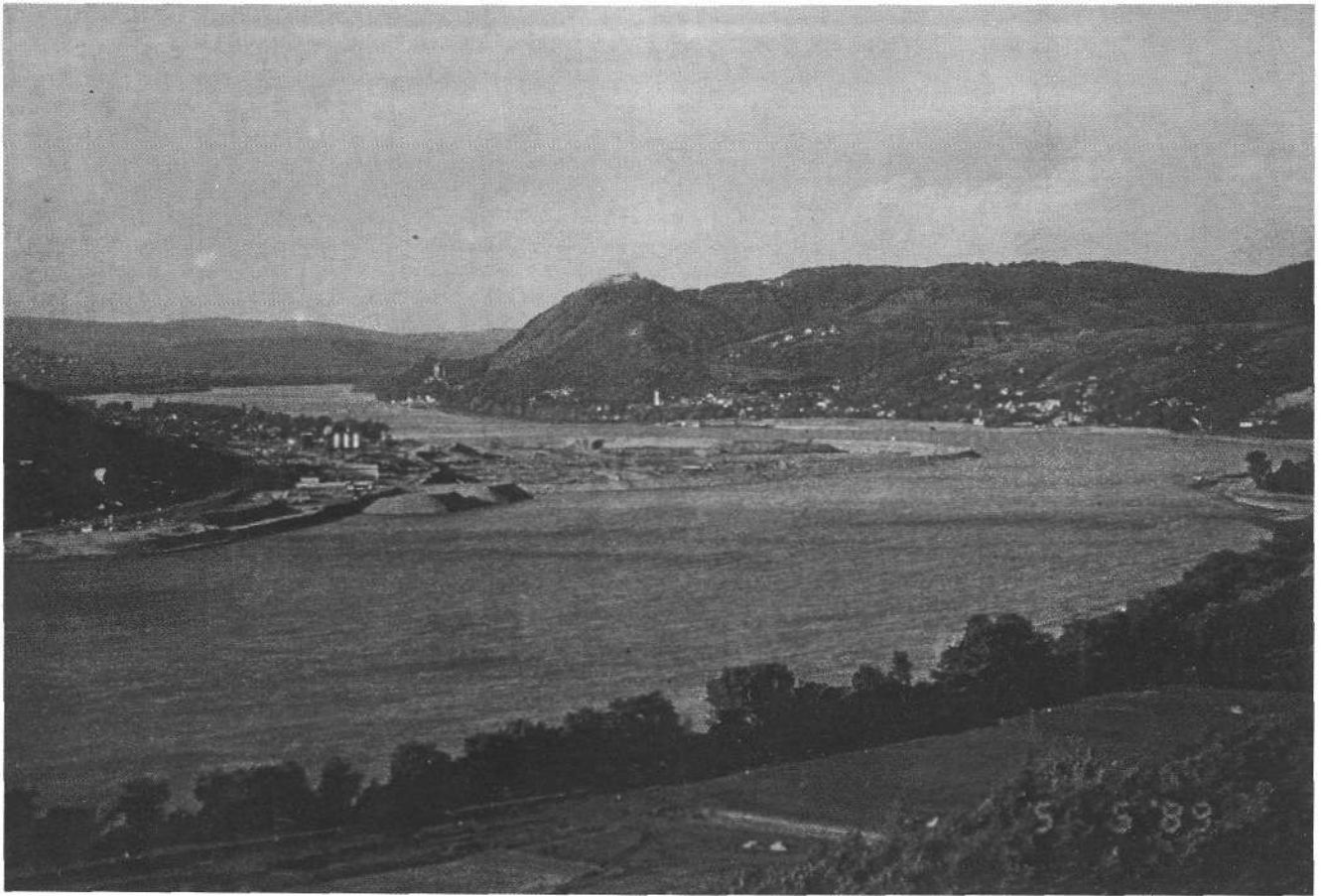
Abb. 12. Blick auf die Baugrube Nagymaros mit dem Umschließungsdamm und dem Umleitungsgerinne der Donau im Jahre 1989; im Hintergrund erkennt man die Ortschaft Visegrad mit der Burgruine.
