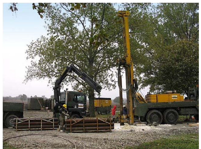
Abb. 8. Bohrung Oggau mit Hilfsverrohrung und Förderung des Bohrgutes im Lufthebeverfahren.
