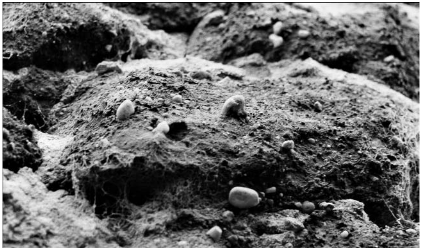
Abb. 45. Burg Neuhaus. Freigewitterte Quarzgerölle als Maß für die Rückwitterung der Tuffite in den Burgmauern.
