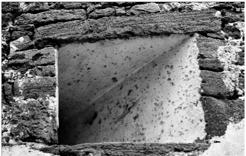
Abb. 41. „Sturz“ (Fensterüberlager) aus dem bemerkenswert biegezugfesten Güssinger Basalt-Tuff. Burg Güssing.
