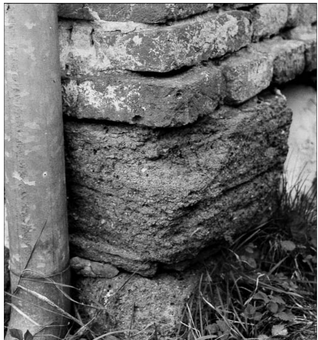
Abb. 46. Feinkörniger Tuffit ausreichender Bausteinqualität; lagerhaft versetzt als Grundbaustein eines Bauernhauses an der Straße Neuhaus – Kalch.
