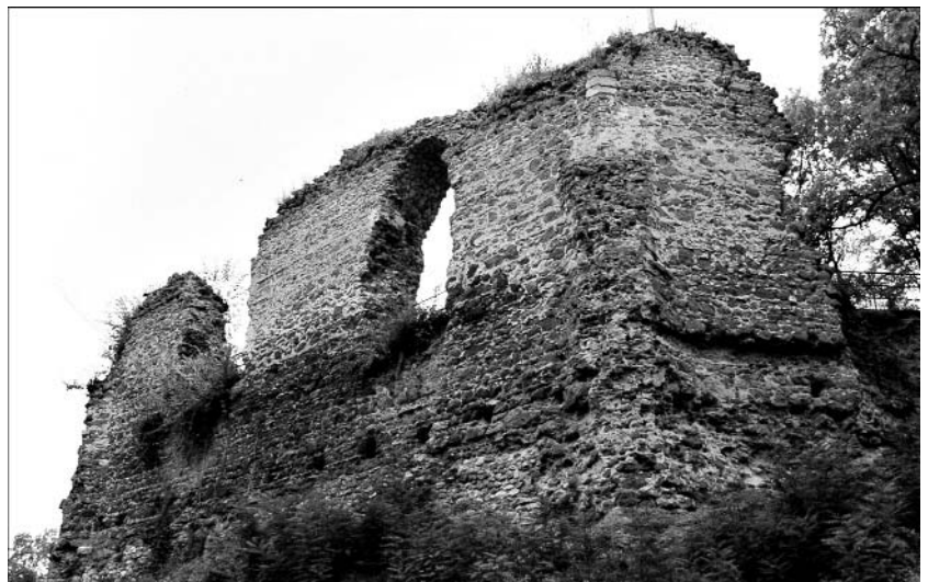
Abb. 44. Burgruine Neuhaus erbaut aus den Tuffiten des Burg- hügels. (Baugrund = Baustoff).
