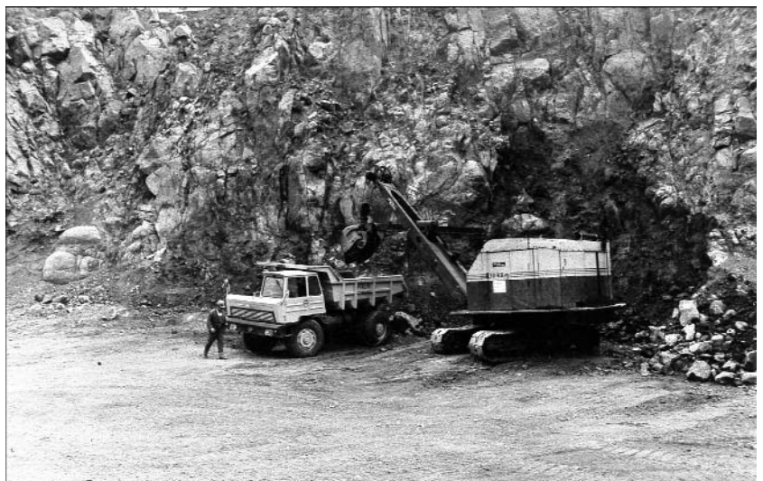
Abb. 17. Haufwerksverladung Mittels Seilzugbagger. Basaltsteinbruch Pauliberg; Abbaustadium 1971.
