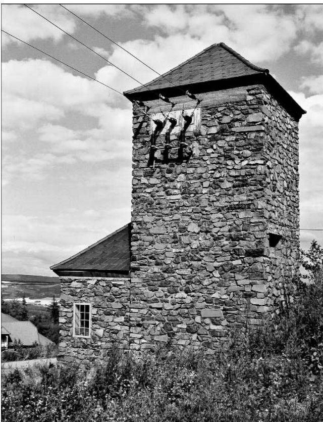
Abb. 25. Trafostation am Pauliberg. Verwendungsbeispiel für den Basalt vom Pauliberg im Hochbau.
