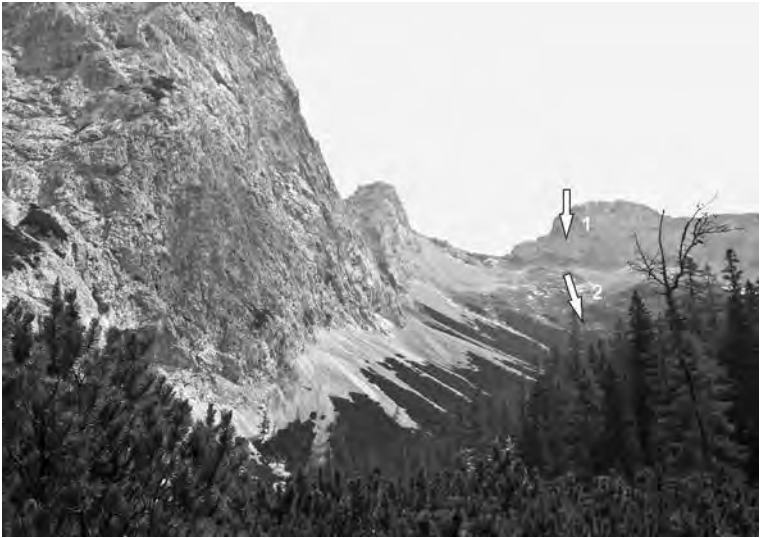
Abb. 5. N–S verlaufende Abrisswand unter den Grießsteinen und die O–W orientierte Abrisswand der Schaufelwand (1). Schichtfläche und Gleitbahn (2). Blickrichtung SSO.
