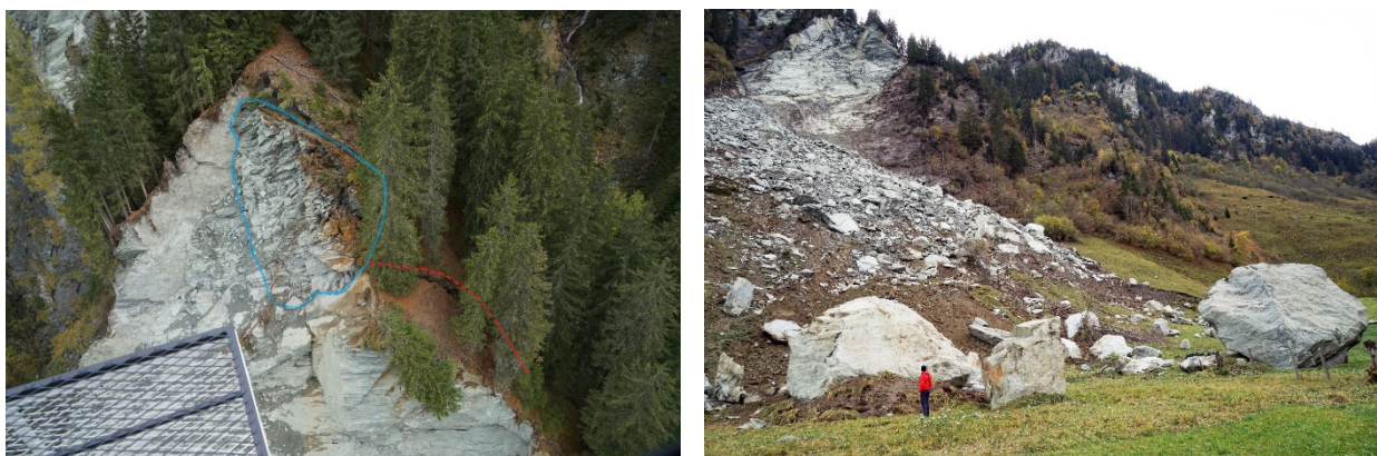
Abb. 11: Felssturzareal in Kartsch in der Gemeinde Hüttschlag nach dem 24. Oktober 2019. Anbruchgebiet (links) und Sturzbahn sowie Akkumulationsbereich (rechts) (© Fotos: Gerald Valentin/Land Salzburg; Quelle: Webseite des Landes Salzburg) [1].
