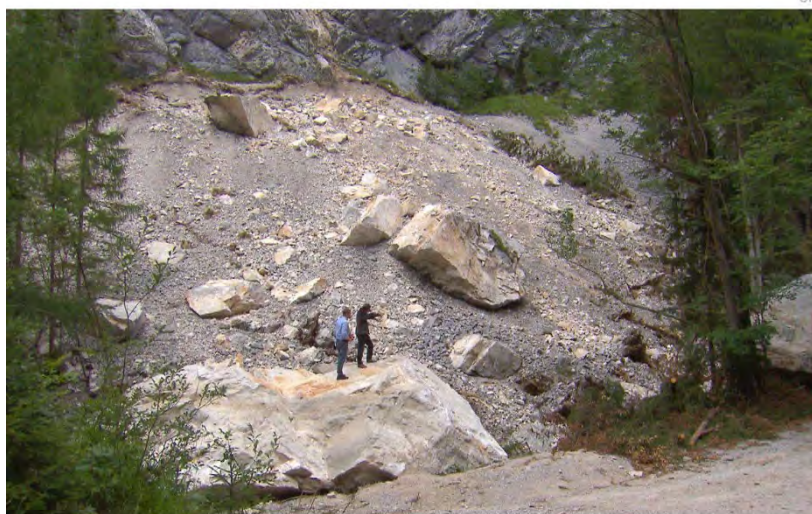
Abb. 22: Berichterstattung über unbelehrbare Wanderer auf der Mairalm-Forststraße, die, alle Absperrungen ignorierend, das Felssturzareal passieren (© oberes Foto: mjp-Ziviltechniker; Quelle: ORF-online) [24].
