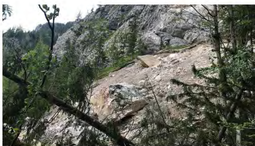
Die Felswand über der Forststraße ist alles andere als stabil, sagen Experten. Bild: AFA
