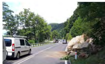
Die Stelle, an der sich der Felssturz ereignet hat © LFD
