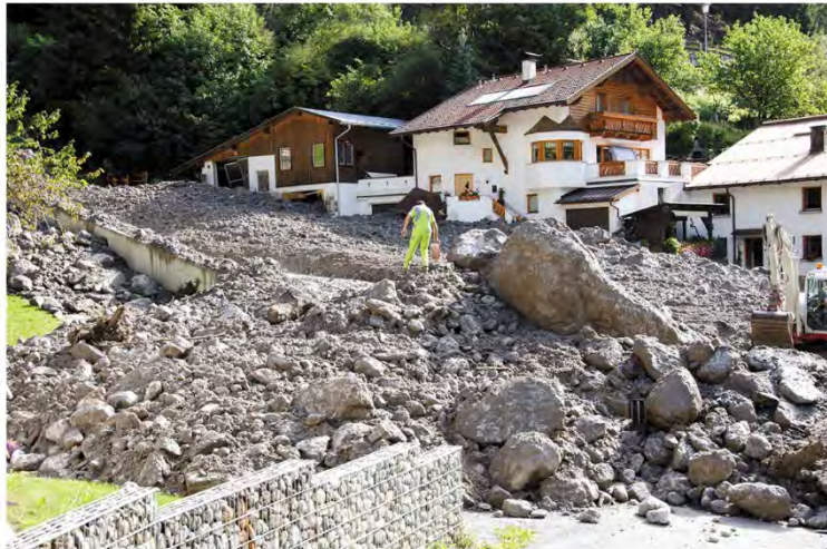
Beim Murenabgang wurden mehrere Häuser beschädigt. RS-Foto: Wechner
