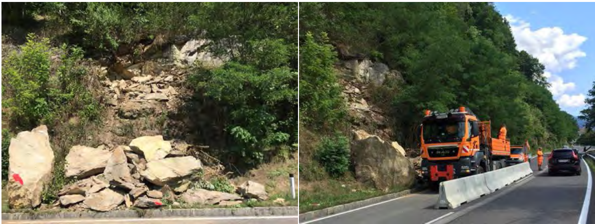
Abb. 14: Die Stelle des Felsausbruches an der Millstätter Bundesstraße zwischen Dellach und Pesenthein im Gemeindegebiet von Millstatt (Bundesland Kärnten) vom 4. August 2019 (© Fotos: Horst Tuppinger/Straßenbauamt Spittal; Quelle: „Kleine Zeitung“-online) [15].
