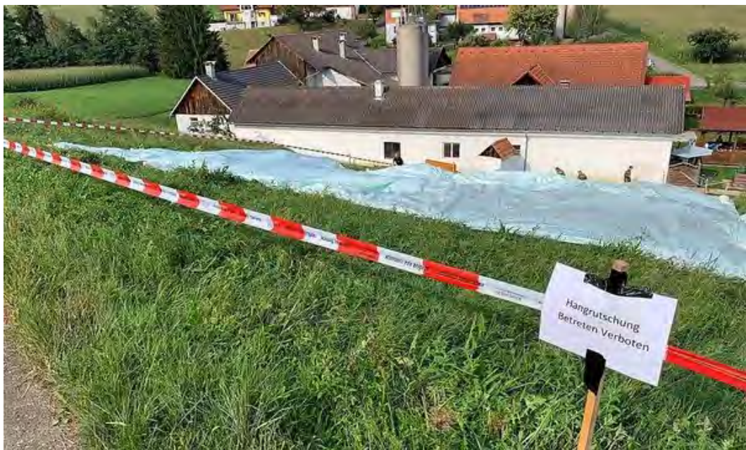
Abb. 44: Hangrutschung in Thien in der Gemeinde Gnas am 24. August 2019 (© Foto: Karner/BFVFB; Quelle: „Kleine Zeitung“-online) [43].
