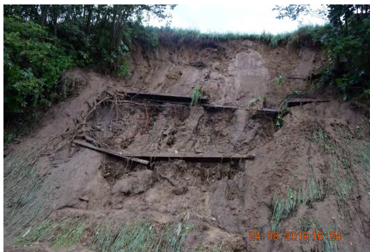
Abb. 42: Hangrutschung im Raum Granitzen in der Gemeinde Obdach am 24. August 2019 (© Foto: FF Obdach; Quelle: Webseite der Freiwilligen Feuerwehr Obdach) [40].
