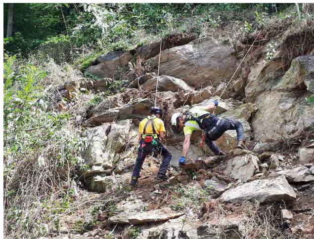
Es wird genau geprüft, ob es zu weiteren Felsstürzen kommen kann
