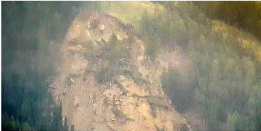
Ein Hang oberhalb der Villgratentalstraße kam ins Rutschen. Foto: Brunner Images
