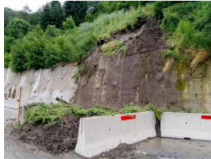
Bereits vorhandene Betonleitwände verhinderten eine weitere Ausbreitung des Hangrutsches an der Ellbögener Straße.
