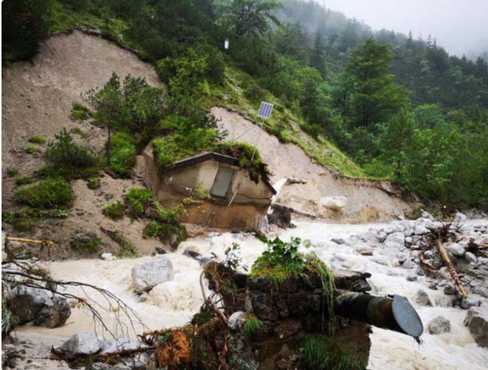
Abb. 22: Die schwer beschädigte Brunnstube „Stollenquelle“ im Lastal in der Gemeinde Sankt Ulrich am Pillersee (Bundesland Tirol) nach der Unwetternacht vom 28. auf den 29. Juli 2019 (© Foto: Gemeinde Sankt Ulrich am Pillersee; Quelle: „Bezirksblätter“-online) [25].
