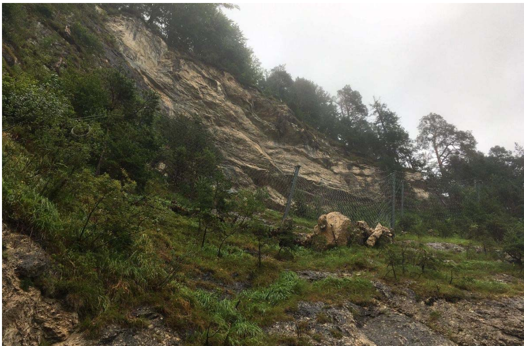
Abb. 21: Berichterstattung über einen Blocksturz in Richtung der Brandenberger Straße (L 4) im Gemeindegebiet von Brandenberg (Bundesland Tirol) am 27. Juli 2019 und dessen Folgen (© Foto: K. Gröbner/Land Tirol; Quelle: Webseite des Landes Tirol) [23].
