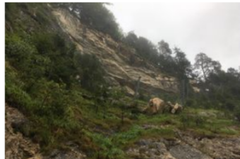
Ein Felsbrocken im Auffangnetz ist so groß, dass er von einer Spezialfirma gesprengt werden muss.
