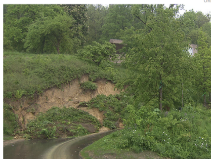
Die Zufahrt zu dem umstrittenen Haus rechts oben im Bild wurde verschüttet
