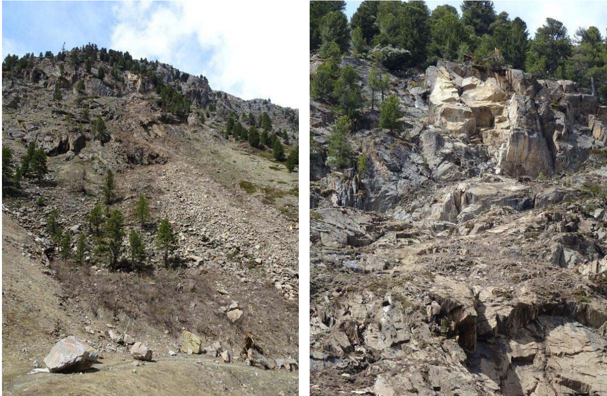
Abb. 14a-b: Abbruchstelle des Felssturzes an der Venter Straße (L 240) am 20. Mai 2019 im Gemeindegebiet von Sölden (© Fotos: Land Tirol; Quelle: Webseite des Landes Tirol) [12].
