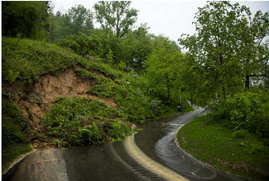
Abb. 25: Hangrutschung an einer Zufahrt in der Gemeinde Lochau am 21. Mai 2019 (© Foto: Paulitsch; Quelle: „Vorarlberg“-online) [25].
