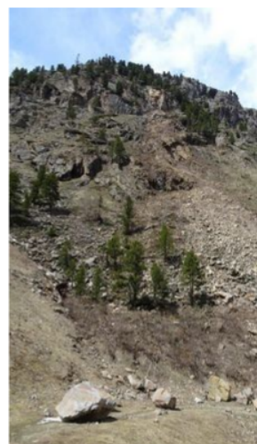
Als Sofortmaßnahme werden absturzgefährdete Felsbereiche entfernt.
