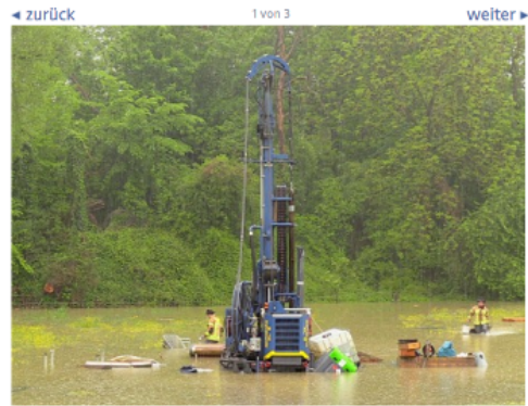
Bohrturm in Höchst
