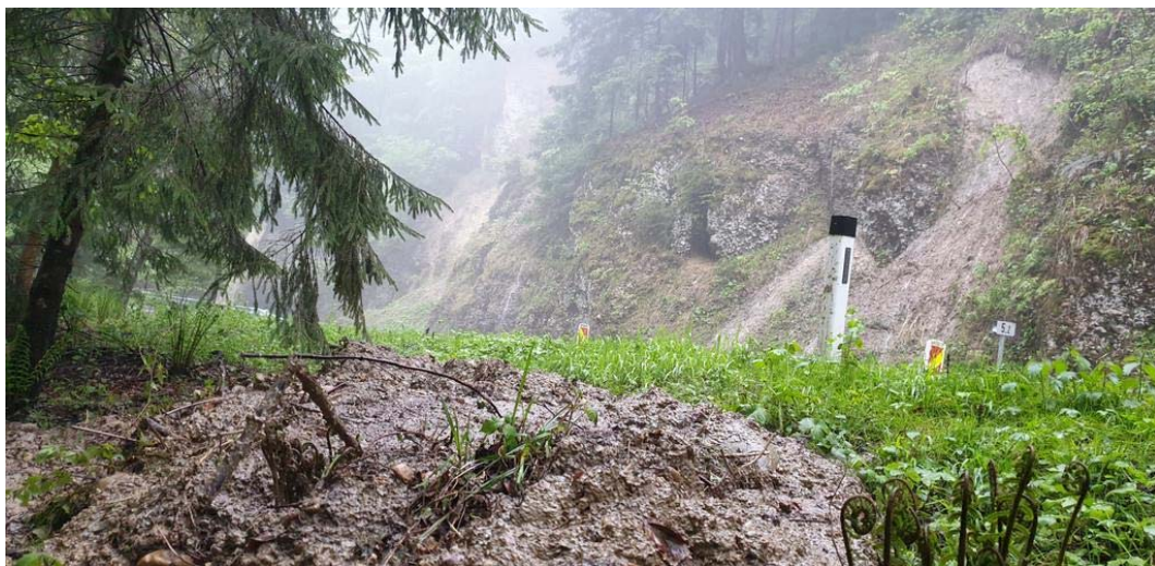
Abb. 24: Hangmure an der Eichenberger Straße (L 11) auf Höhe Straßenkilometer 5,2 in der Gemeinde Eichenberg am 20. Mai 2019 (© Foto: M. Shourot; Quelle: „Vorarlberg“-online) [24].
