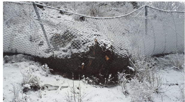
Abb. 11: Pressemeldung des Landes Tirol zur Wirksamkeit eines Steinschlagschutzes an der Tiroler Straße bei Urgen im Zuge einer Lockergesteinsrutschung am 10. Februar 2019 (© Fotos: Bezirksbauamt Imst; Quelle: Land Tirol-online) [16].
