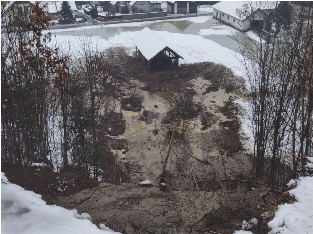
Abb. 14: Hangmure in Oberamlach in der Stadtgemeinde Spittal an der Drau (© FF Sankt Peter/Spittal; Quelle: Webseite der FF Sankt Peter/Spittal) [17].
