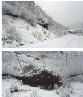
100 Kubikmeter Fels und Geröll sind im Bereich Urgen an der L 76 Landecker Straße vom seit 2016 bestehenden Steinschlagschutz zurückgehalten worden.
