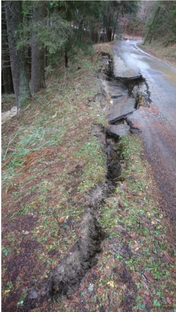
Abb. 11a (links) und b (rechts): Anriss (links) und voll ausgebildete Rutschung infolge des Wasserrohrbruches an der Glaserstraße in der Gemeinde Pinggau in der Steiermark am 3. Dezember 2018 (© Fotos: FF Pinggau, Quelle: Webseite der FF Pinggau) [9].
