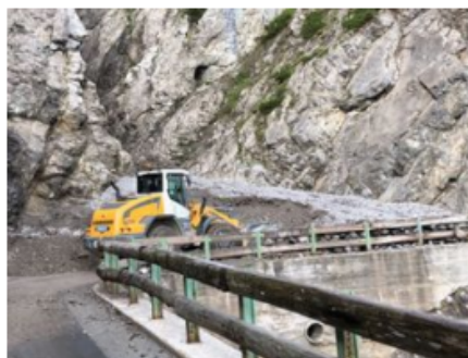
Derzeit werden Räumungsarbeiten durch die Straßenmeisterei durchgeführt und die Schutzwälle freigelegt.
