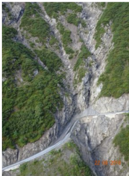
Die Hahntennjochstraße wurde von mehreren kleineren Muren verschüttet.
