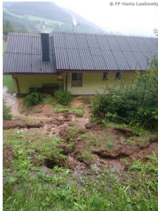
Abb. 7: Hangmure hinter einem Wohngebäude in der Gemeinde Maria Lankowitz in der Weststeiermark am 10. August 2018 (© Foto: Webseite der FF Maria Lankowitz; Quelle: Webseite der FF Maria Lankowitz) [7].
